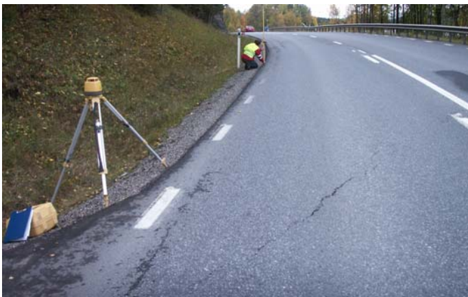
Figur 6 Kurvan sedd mot olycksbilens körriktning. I kurvans tväraste del (bortom mätkarlen på bilden) var tvärlutningen cirka 8 procent. I bildens nedre vänstra hörn börjar infartsvägen i förgrunden av Figur 7. [Foto nr 1180 i bildbilagan] 14
