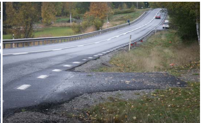
Figur 7 Kurvutgången i olycksbilens körriktning. Röda sifferskyltar vid aväkningsplatsen. Se också Illustration 5 i Nesmarks rapport. I bildens vänsterkant syns en ganska abrupt förändring i vägbanans lutning, som kan ha råkat samverka med motorbromsningen och punkteringen, så att bredsladden förvärrades. [Foto nr 1279] 14
